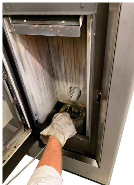
Fig. 37 - Limpieza con escobilla
