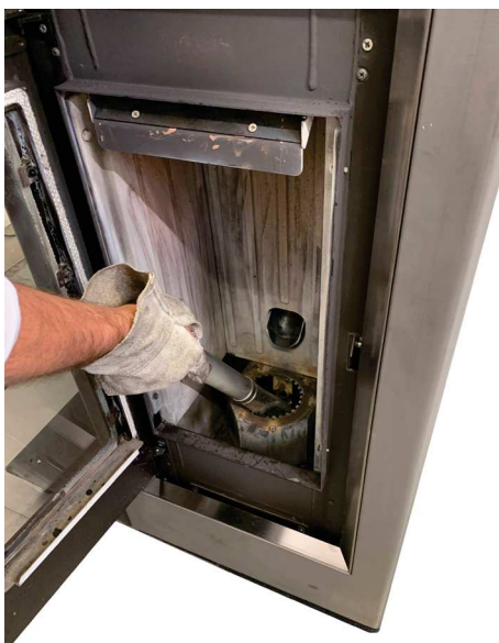
Fig. 36 - Limpieza alojamiento brasero
