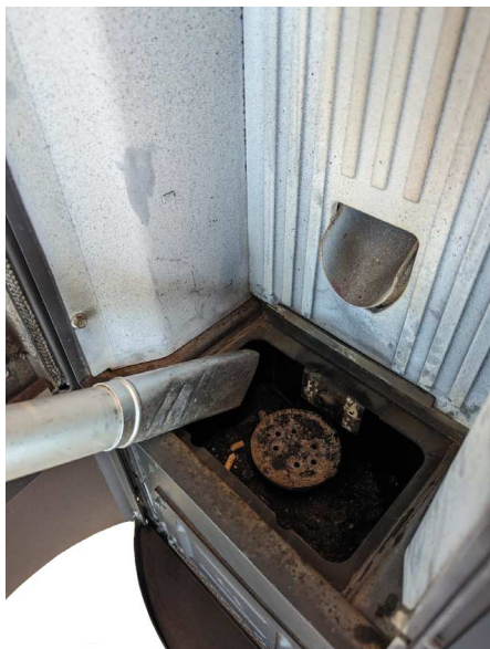
Fig. 40 - Limpieza alojamiento brasero
