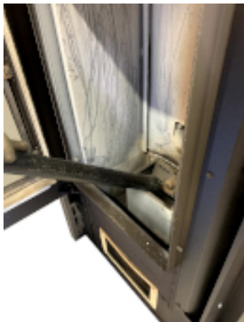
Fig. 35 - Limpieza alojamiento brasero
