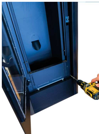
Fig. 41 - Extracción de los tornillos traseros
