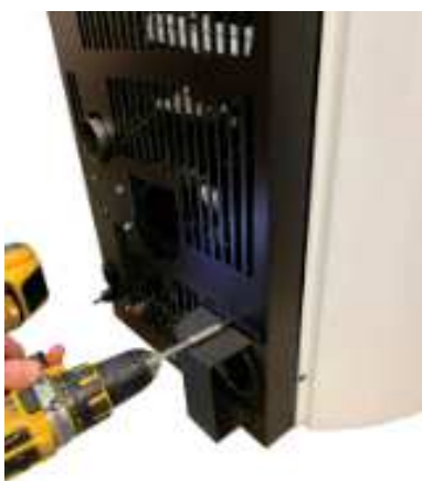
Fig. 72 - Extracción del desviador
