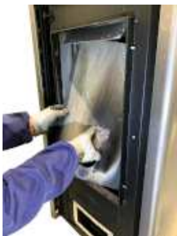
Fig. 95 - Extraiga la parte trasera del hogar
