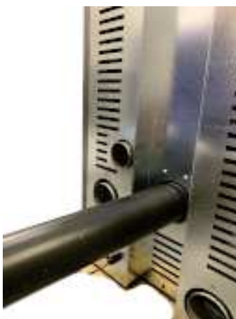
Fig. 55 - Conexión de la descarga de humos
