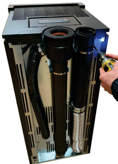
Fig. 78 - Bloqueo del tubo d. 80 mm
