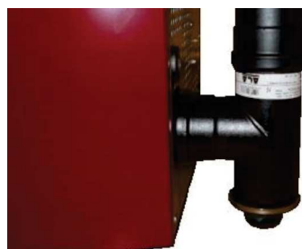
Fig. 91 - Limpieza canal de humos
