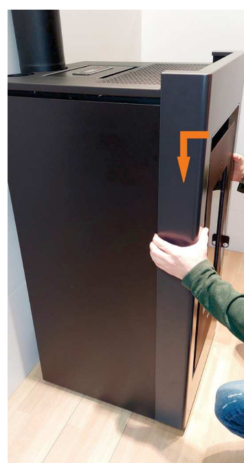
Fig. 32 - montaje el marco
