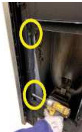
Fig. 92 - Extraiga los tornillos hexagonales
