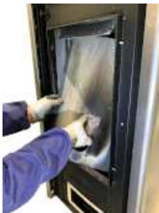
Fig. 125 - Extraiga la parte trasera del hogar
