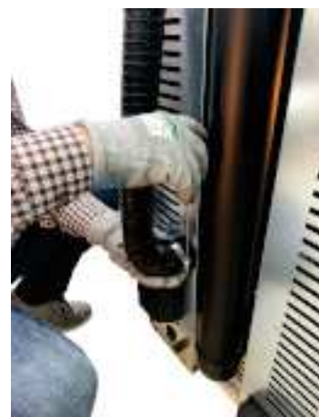
Fig. 78 - Acople el tubo de aire comburente
