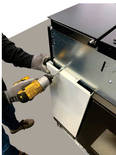
Fig. 39 - Fije los paneles laterales
