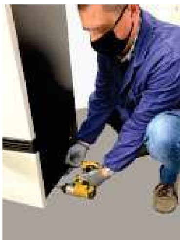
Fig. 68 - Extracción de los tornillos
