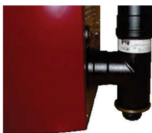
Fig. 119 - Limpieza canal de humos
