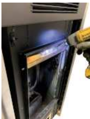
Fig. 120 - Retire el deflector
