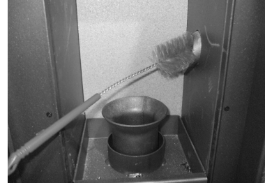
Fig. 33 - Limpieza con escobilla
