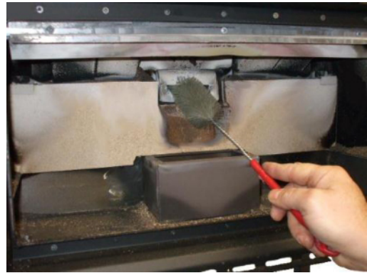
Fig. 49 - Limpieza con escobilla
