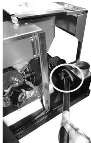
Fig. 40 - Limpieza del canal de humo
