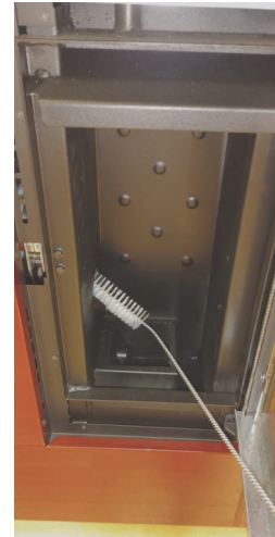
Fig. 35 - Limpieza con escobilla
