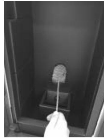
Fig. 36 - Limpieza con escobilla
