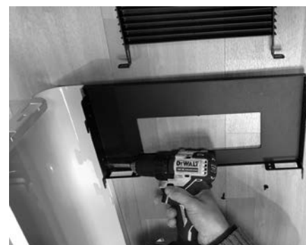
Fig. 19 - Fije el panel al montante
