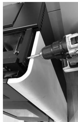
Fig. 27 - Fijación al panel
