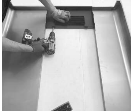
Fig. 32 - Fijación de la rejilla
