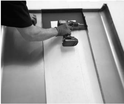
Fig. 31 - Fijación del montante
