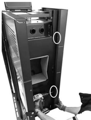
Fig. 48 - Fijación delantera del lateral
