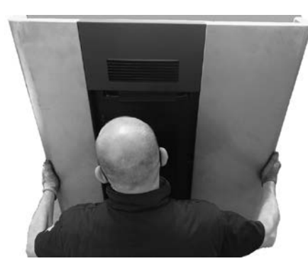
Fig. 35 - Posicionamiento del marco
