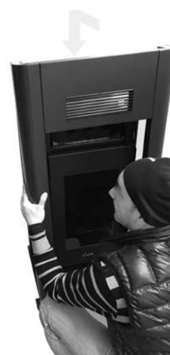
Fig. 13 - Posicionamiento del marco
