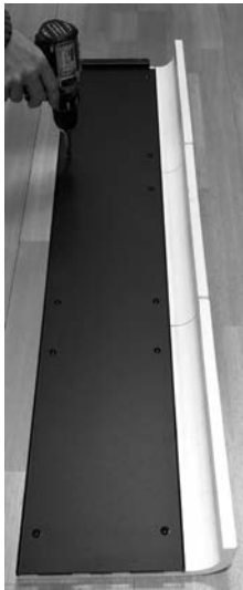
Fig. 24 - Montaje de las mayólicas
