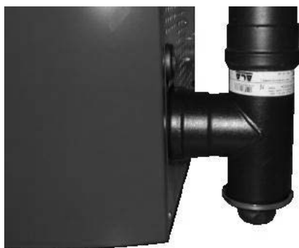
Fig. 75 - Limpieza canal de humos
