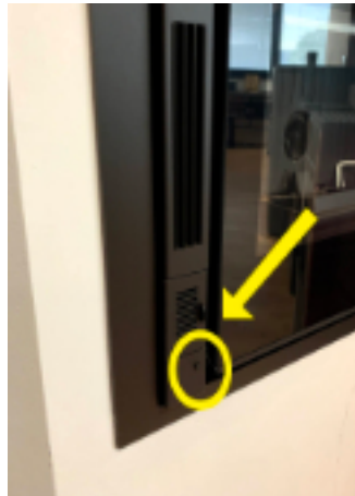
Fig. 31 - Sonda termostato
