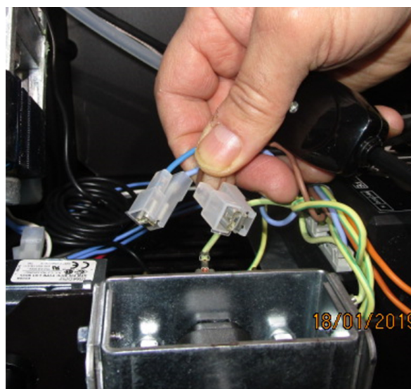
Fig. 88 - Conexión de los terminales faston dobles
