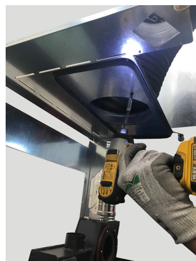
Fig. 68 - Fijar el tubo flexible
