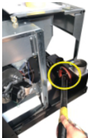
Fig. 114 - Limpieza del canal de humo
