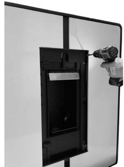
Fig. 41 - Fijación del revestimiento
