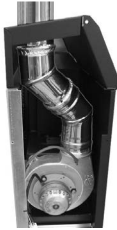
Fig. 20 - Descarga superior humos
