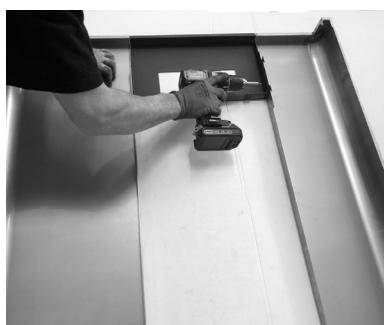
Fig. 40 - Fijación del montante
