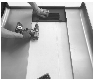
Fig. 41 - Fijación de la rejilla
