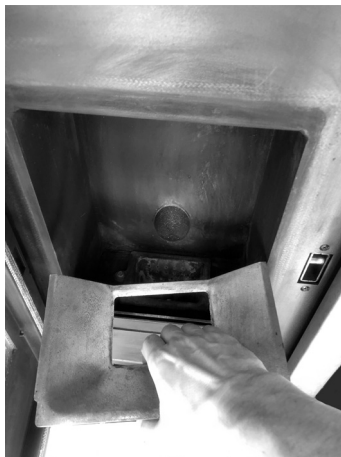
Fig. 84 - Aspire las cenizas
