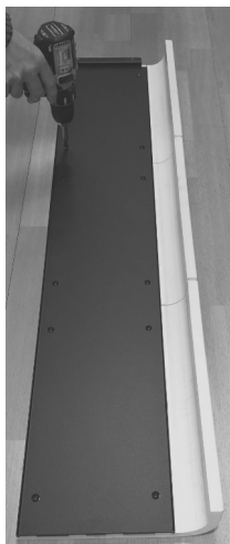
Fig. 28 - Montaje de las mayólicas
