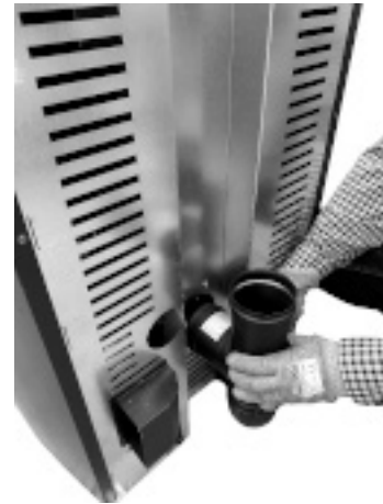
Fig. 71 - Conecte el racor en T
