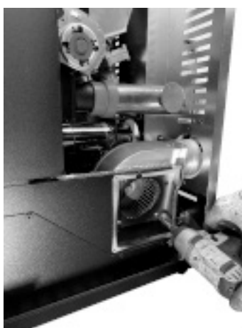
Fig. 83 - Extraiga los tornillos del ventilador
