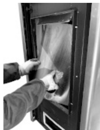
Fig. 124 - Extraiga la parte trasera del hogar
