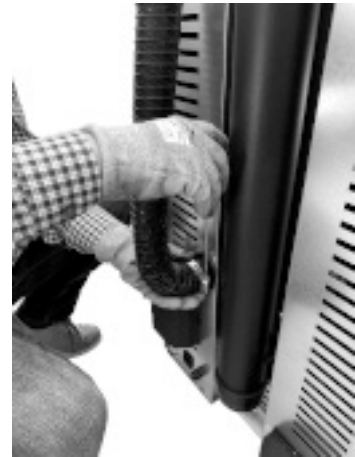
Fig. 77 - Acople el tubo de aire comburente
