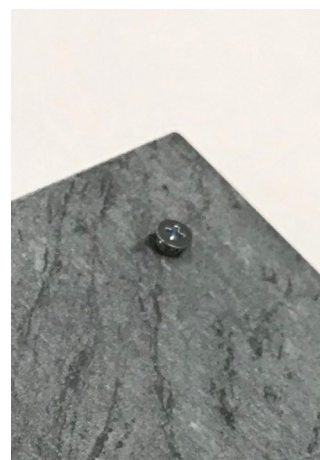
Fig. 37 - El tornillo debe sobresalir
