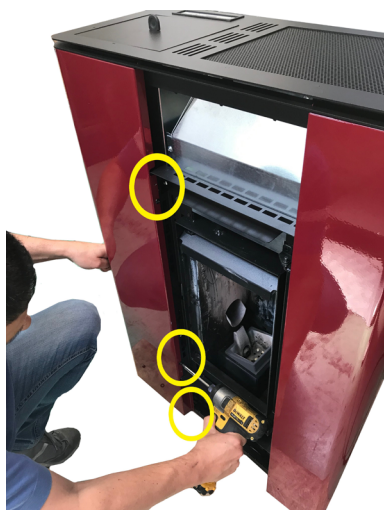
Fig. 53 - Extracción de los tornillos 3
