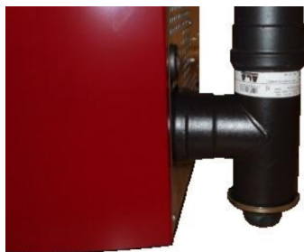
Fig. 86 - Limpieza canal de humos
