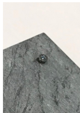
Fig. 37 - El tornillo debe sobresalir
