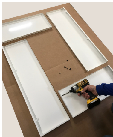
Fig. 29 - Fijación de los paneles 1
