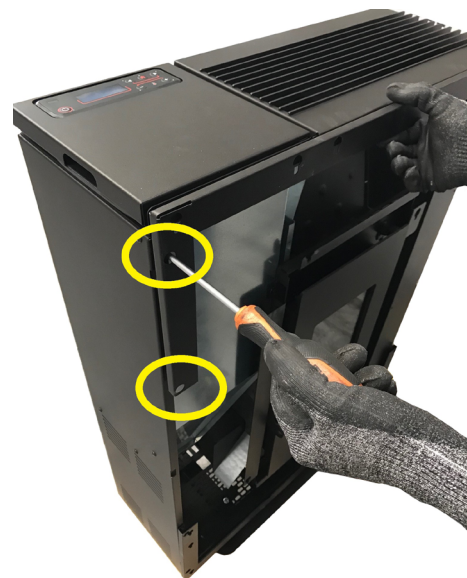
Fig. 35 - Fijación de la abrazadera superior
