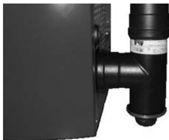
Fig. 114 - Limpieza canal de humos
