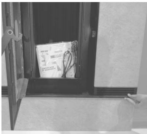
Fig. 60 - Colocar piedra y perfil
