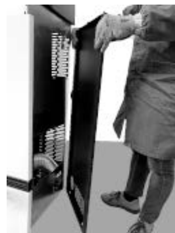
Fig. 63 - Desmontaje de la pared
