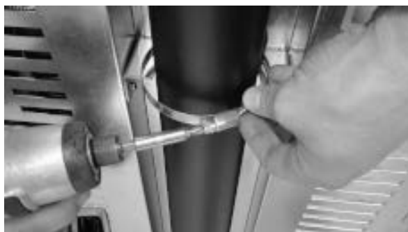
Fig. 74 - Bloquee con la abrazadera
