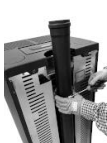
Fig. 70 - Descarga de humos posterior montada
