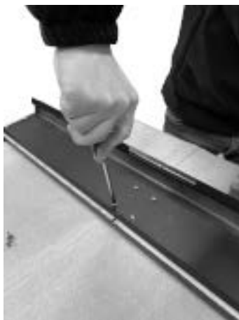
Fig. 33 - Montaje de las mayólicas
