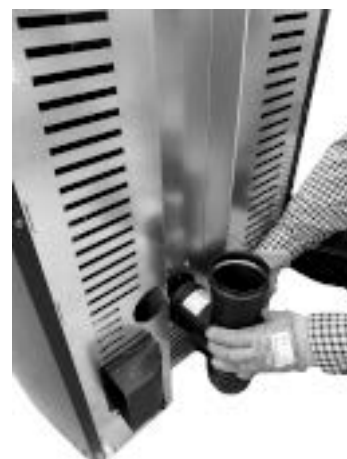
Fig. 67 - Conecte el racor en T
