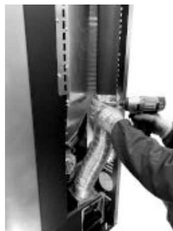
Fig. 83 - Fije los tubos
