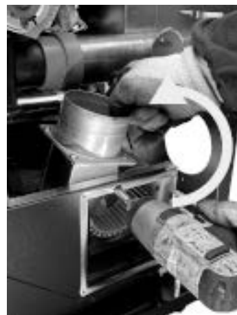
Fig. 80 - Gire el ventilador
