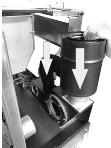
Fig. 84 - Conexión del tubo concéntrico
