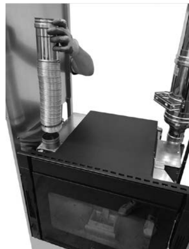
Fig. 68 - Introducción del insertable
