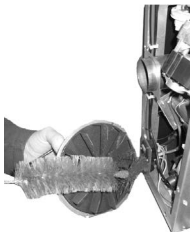
Fig. 102 - Limpieza del aspirador de humos: fase 1
