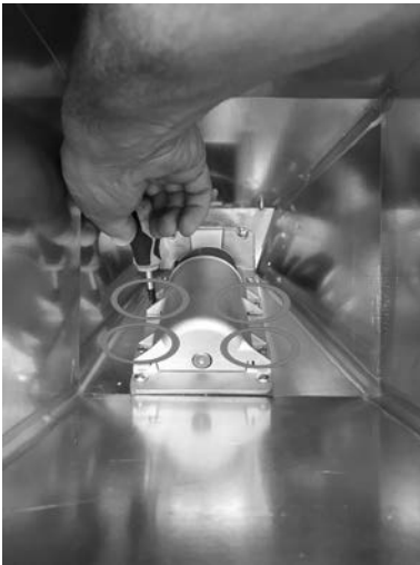
Fig. 92 - Extracción de los tornillos
