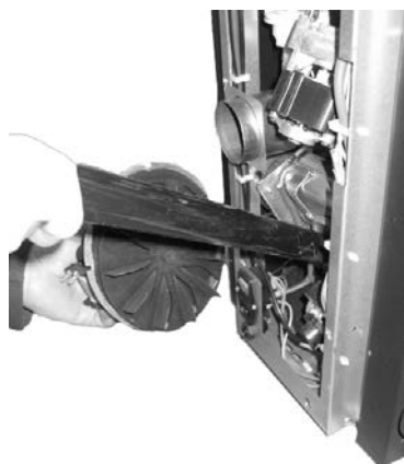
Fig. 103 - Limpieza del aspirador de humos: fase 2
