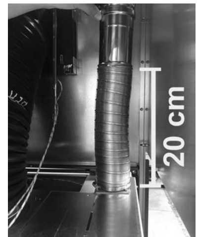
Fig. 56 - Conexión del tubo flexible (vista posterior del insertable)
