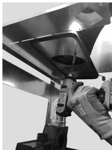
Fig. 73 - Fijar el tubo flexible
