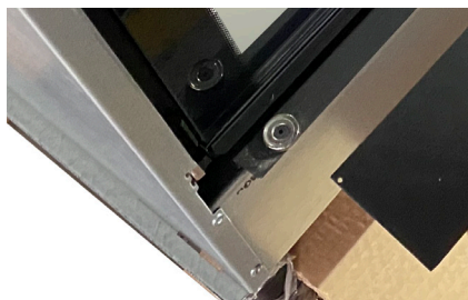
Coloque la baguette inferior en los imanes (no es necesario atornillar)
