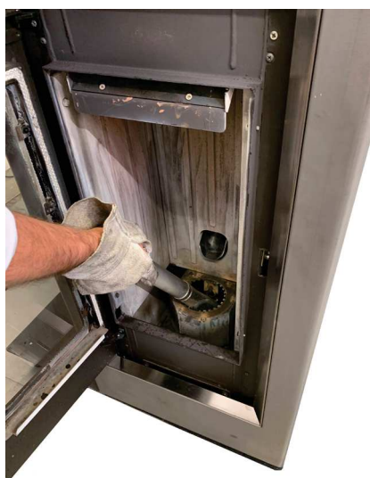
Fig. 34 - Limpieza alojamiento brasero
