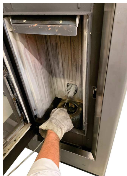
Fig. 39 - Limpieza con escobilla
