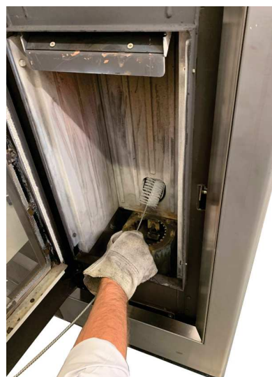
Fig. 35 - Limpieza con escobilla
