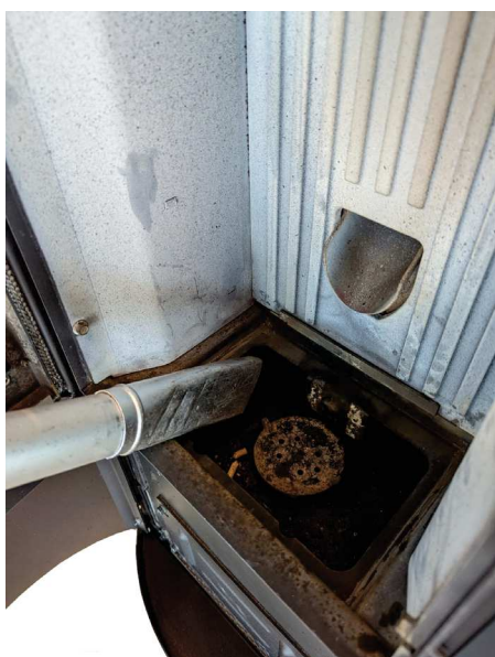
Fig. 38 - Limpieza alojamiento brasero
