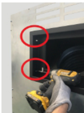
Fig. 69 - Fijación del exterior de la trampilla
