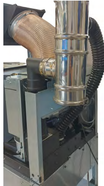
Fig. 79 - Conexión del tubo concéntrico + aire comburente
