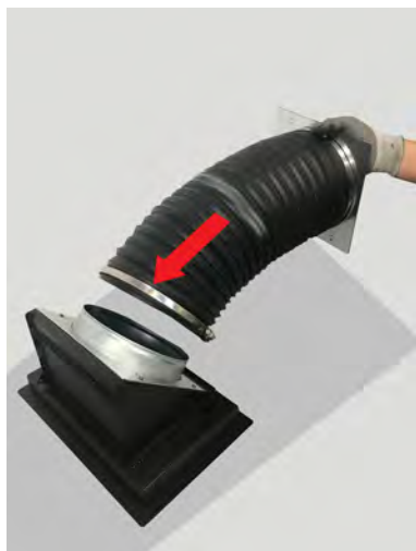
Fig. 63 - Conectar el tubo flexible
