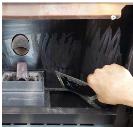
Fig. 102 - Retire la tapa de inspección
