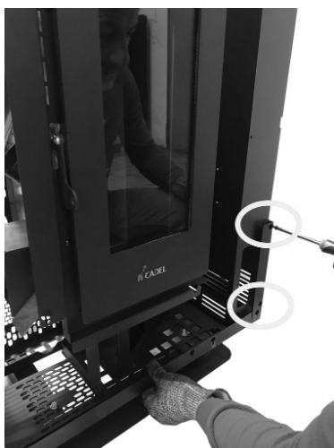
Fig. 28 - Fijación de la abrazadera inferior
