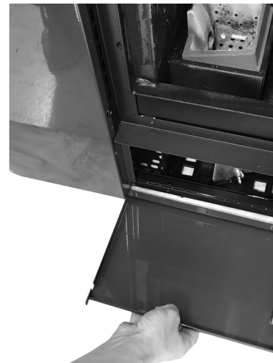
Fig. 42 - Desmontaje de las placas frontales delanteras
