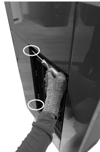
Fig. 30 - Fijación de los tornillos
