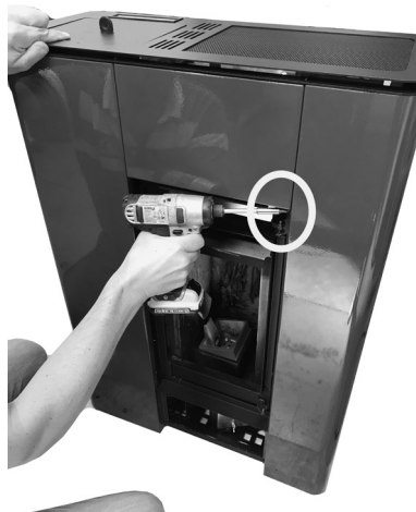
Fig. 41 - Extracción de los tornillos 1
