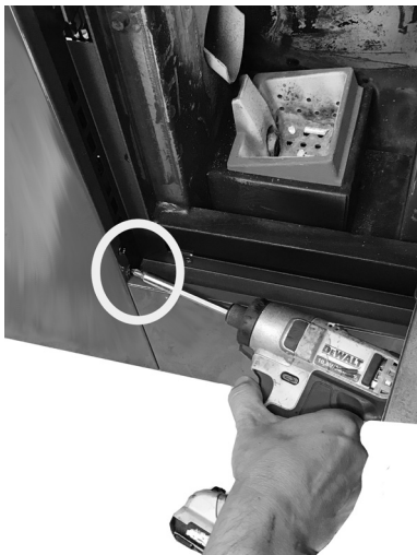
Fig. 40 - Extracción de los tornillos 1
