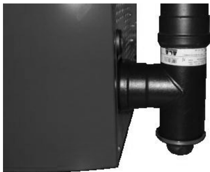
Fig. 59 - Limpieza canal de humos
