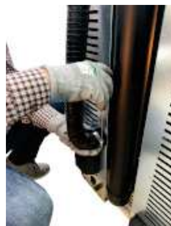
Fig. 45 - Acople el tubo de aire comburente
