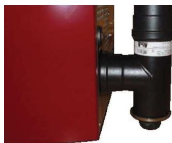
Fig. 70 - Limpieza canal de humos
