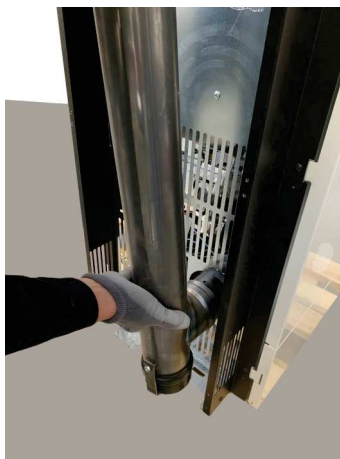
Fig. 41 - Acoplamiento del tubo d. 80 mm
