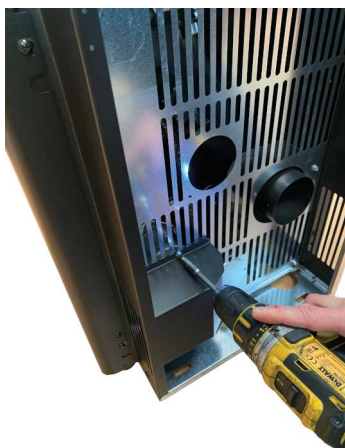
Fig. 51 - Extracción del desviador
