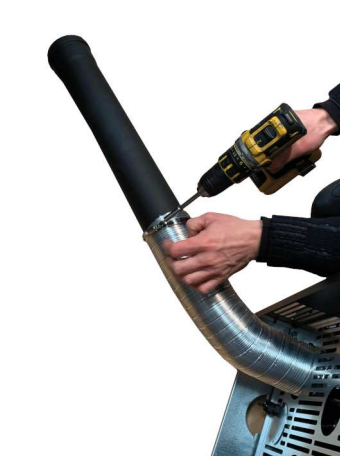
Fig. 55 - Conexión del tubo d. 80 mm
