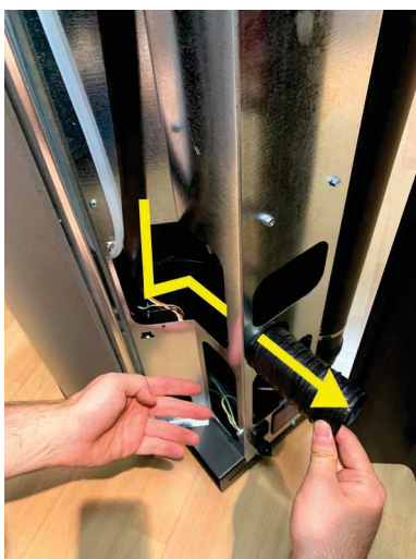
Fig. 65 - Paso del tubo flexible 1
