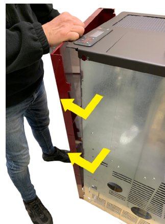
Fig. 43 - Retire las paredes laterales
