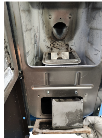
Fig. 80 - Retire la tapa de inspección
