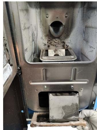
**Fig. 80 - Retire la tapa de inspección**
