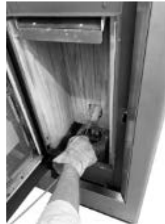
Fig. 36 - Limpieza con escobilla
