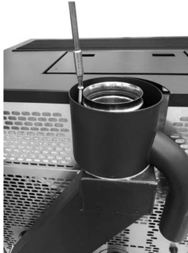
Fig. 44 - Fijar el tubo concéntrico
