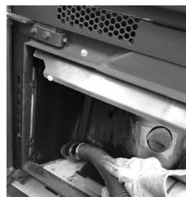
Fig. 74 - Aspire las cenizas
