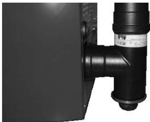
Fig. 66 - Limpieza canal de humos
