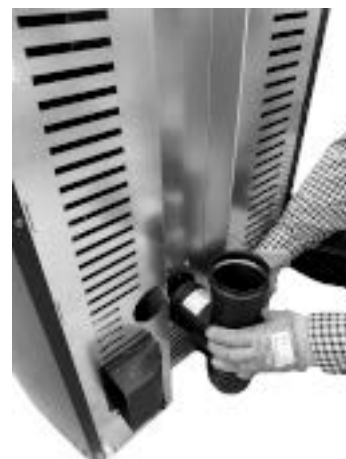
Fig. 47 - Conecte el racor en T
