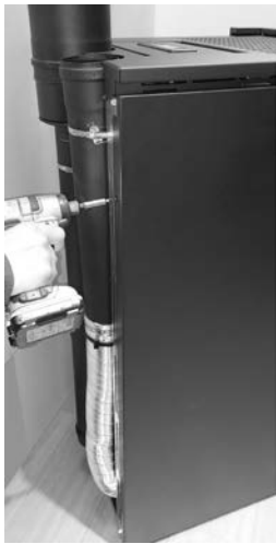
Fig. 21 - Extracción de los tornillos traseros
