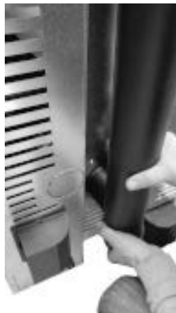
Fig. 52 - Acople el tubo d.80 mm
