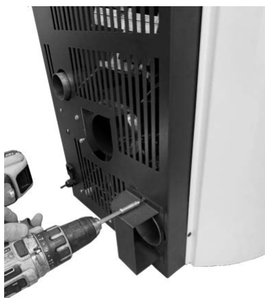
Fig. 59 - Extracción del desviador
