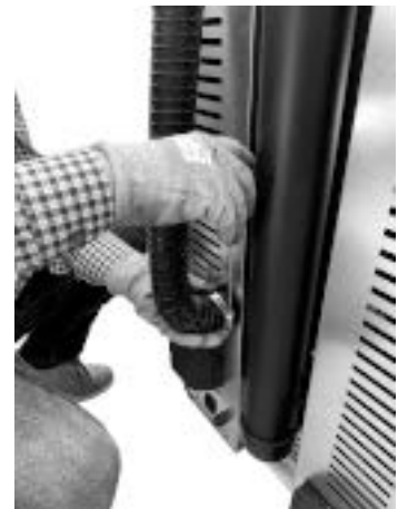
Fig. 53 - Acople el tubo de aire comburente
