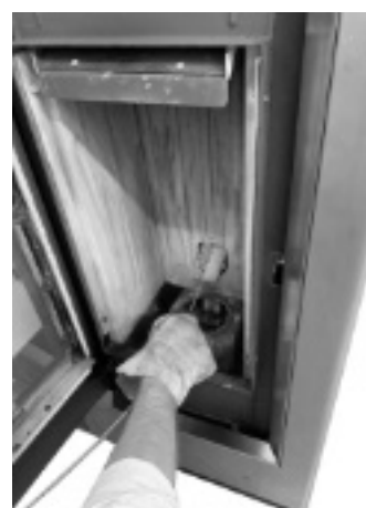
Fig. 39 - Limpieza con escobilla
