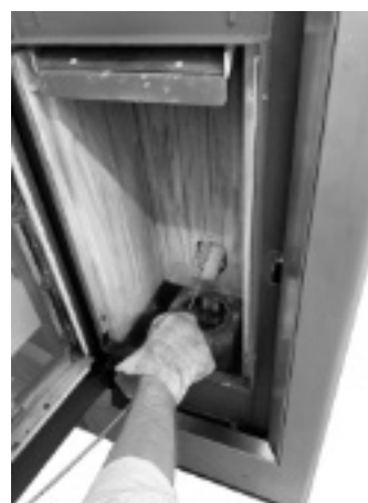
Fig. 35 - Limpieza con escobilla
