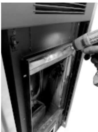
Fig. 48 - Retire el deflector
