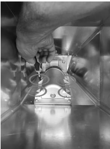
Fig. 46 - Extracción de los tornillos
