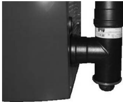
Fig. 39 - Limpieza canal de humos
