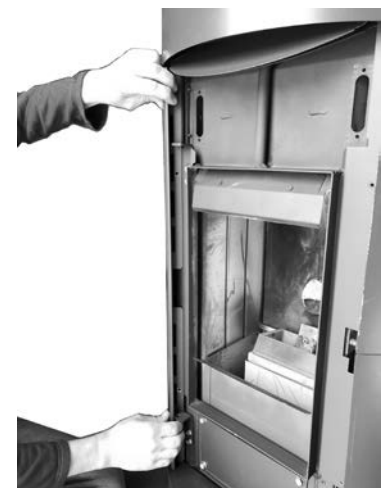
Fig. 25 - Desmontaje de los perfiles anteriores (der e izq).
