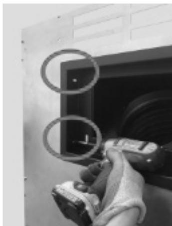
**Fig. 70 - Fijación del exterior de la trampilla**
