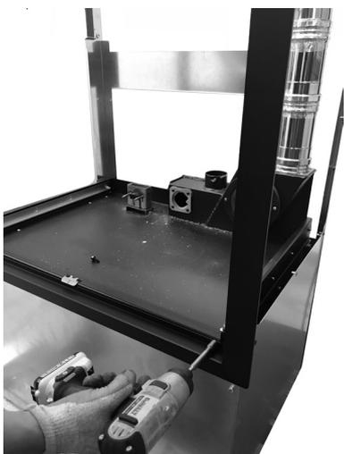
Fig. 76 - Fijación frontal
