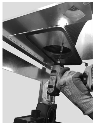
**Fig. 69 - Fijar el tubo flexible**
