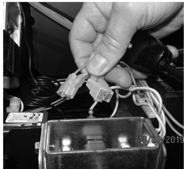
*Fig. 89 - Conexión de los terminales faston dobles*
