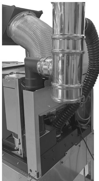
*Fig. 80 - Conexión del tubo concéntrico + aire comburente*
