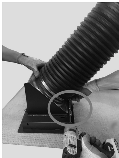
Fig. 65 - Apriete la abrazadera
