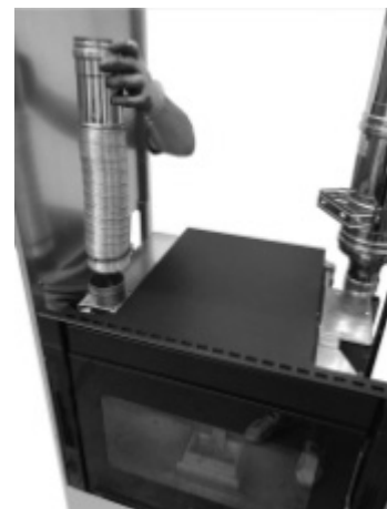
Fig. 63 - Introducción del insertable
