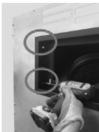
Fig. 70 - Fijación del exterior de la trampilla
