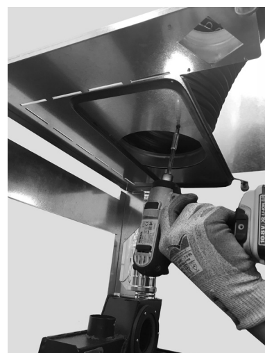
Fig. 69 - Fijar el tubo flexible
