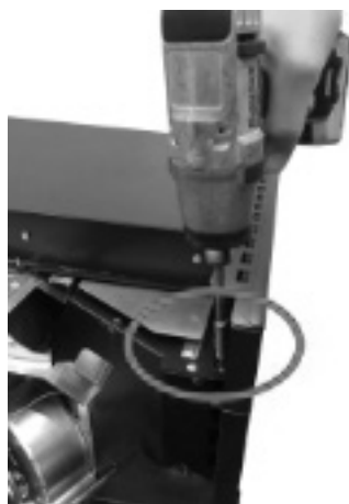
Fig. 57 - Fijación delantera del cajón
