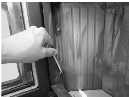
Fig. 110 - Extracción de los tornillos
