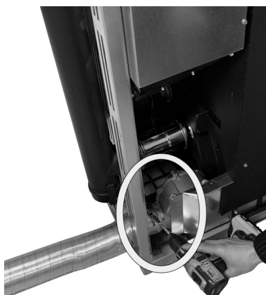
Fig. 56 - Bloquee el tubo flexible
