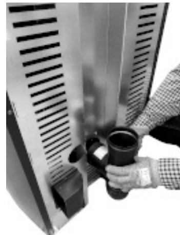
Fig. 41 - Conecte el racor en T
