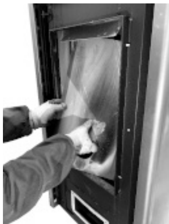
Fig. 77 - Extraiga la parte trasera del hogar
