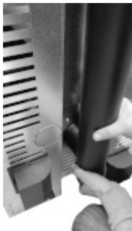
Fig. 46 - Acople el tubo d.80 mm
