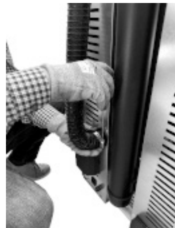
Fig. 47 - Acople el tubo de aire comburente
