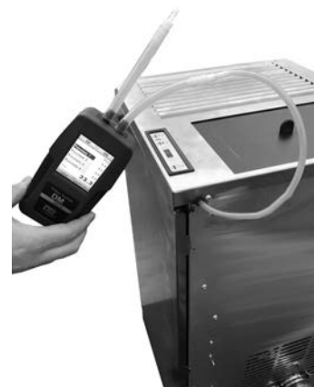
Fig. 74 - Conexión del presostato digital
