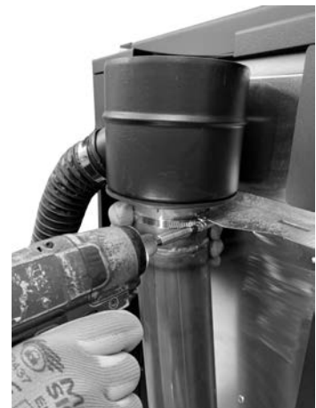
Fig. 50 - Bloqueo con abrazadera
