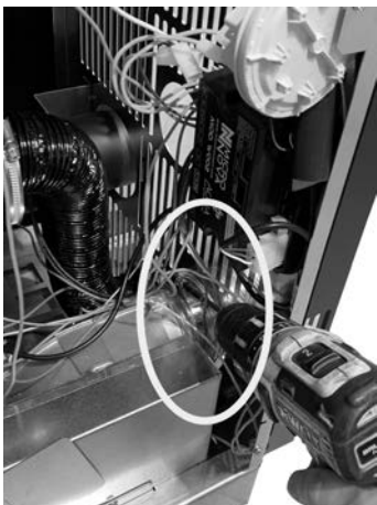
Fig. 62 - Bloqueo del tubo flexible
