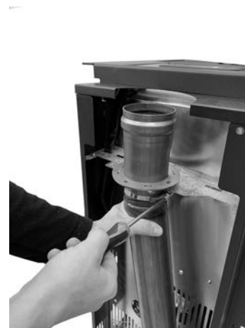
Fig. 44 - Bloqueo con abrazadera
