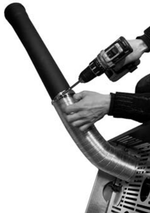
Fig. 63 - Conexión del tubo d. 80 mm
