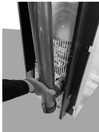
Fig. 49 - Acoplamiento del tubo d. 80 mm
