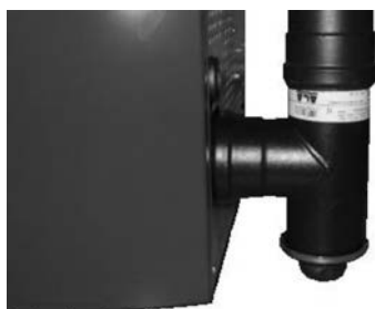
Fig. 75 - Limpieza canal de humos
