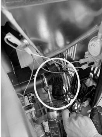
Fig. 45 - Extracción del tubo flexible
