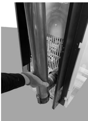
Fig. 43 - Acoplamiento del tubo d. 80 mm
