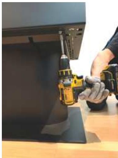
Fig. 18 - Fijación del pedestal
