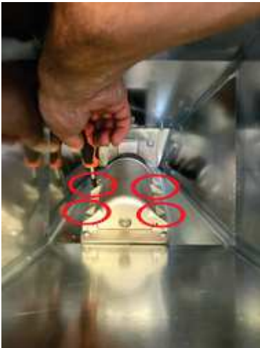
Fig. 54 - Extracción de los tornillos
