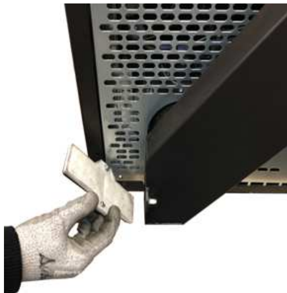
Fig. 66 - Limpieza canal de humos
