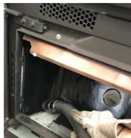
Fig. 73 - Aspire las cenizas
