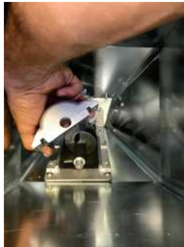
Fig. 55 - Extracción de la cobertura
