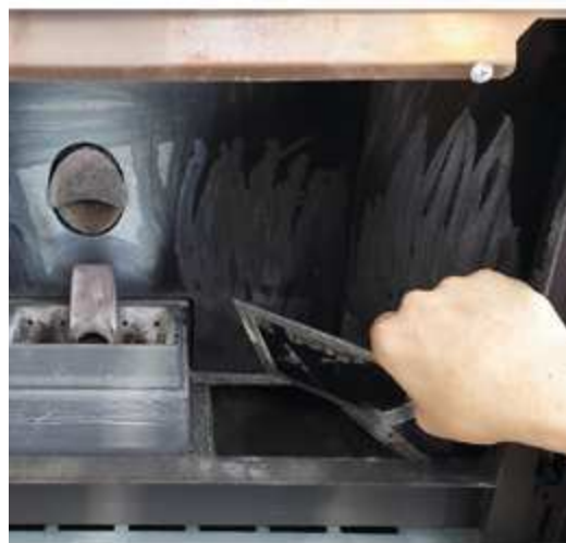
Fig. 68 - Retire la tapa de inspección
