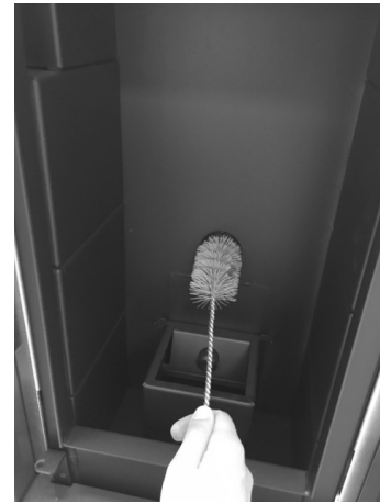
Fig. 24 - Limpieza con escobilla
