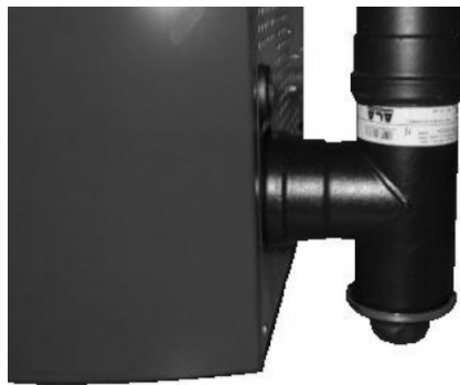
Fig. 65 - Limpieza canal de humos
