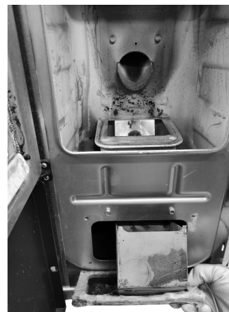
Fig. 70 - Retire la tapa de inspección
