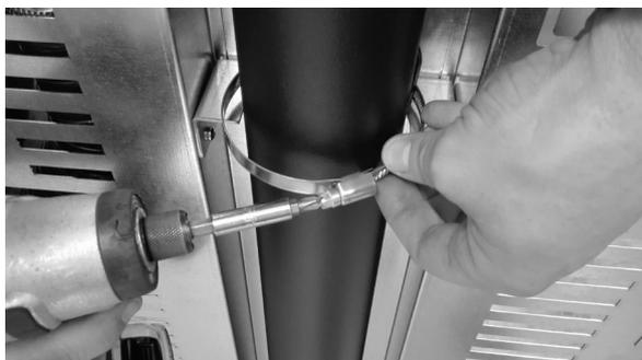
**Fig. 49 - Bloquee con la abrazadera**
