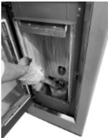
Fig. 33 - Limpieza alojamiento brasero
