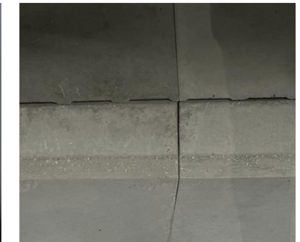
Interior refractory concrete Innenverkleidung Feuerfestbeton
